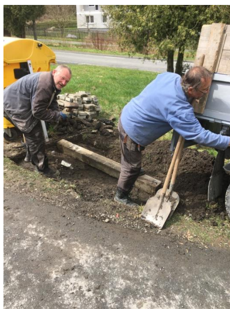
Zhotovení podesty pro kontejner na sklo
